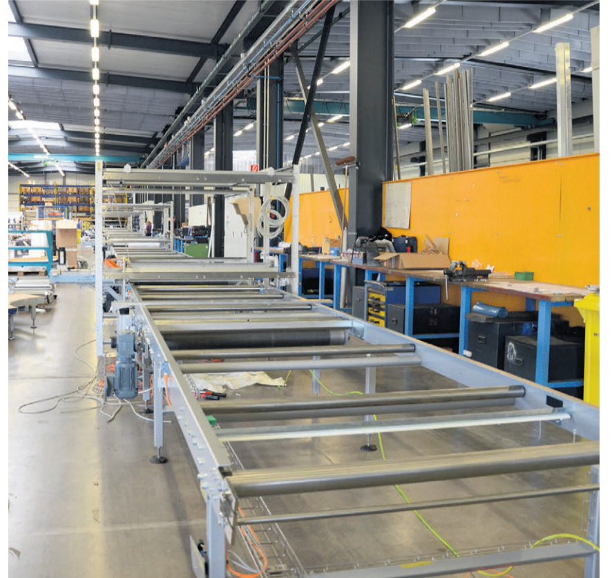
Hier werden später Guetzli und Schokoriegel befördert und gespeichert.
