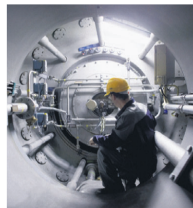
Ständige Überprüfungen, wie hier die Gehäuseasse einer Turbine, gehören zum Alltag.
