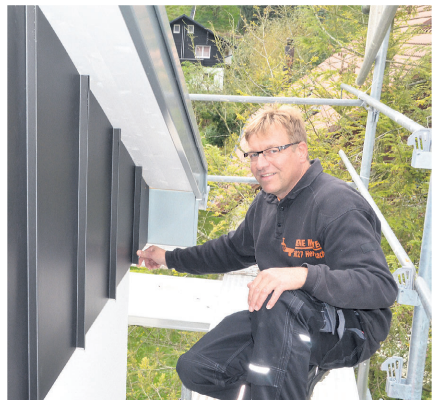
Geschäftsführer René Meyer zeigt die Spengler-Arbeit an einer Hausfassade, gleich unterhalb des Daches.
