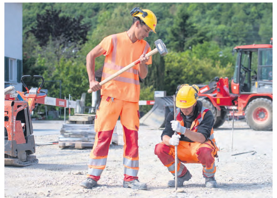
Strassenbau-Lernende beim Anzeichnen auf der Baustelle Ostumfahrung Bad Zurzach.
